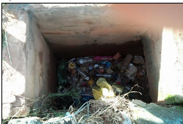
Limpeza de boca de lobo
