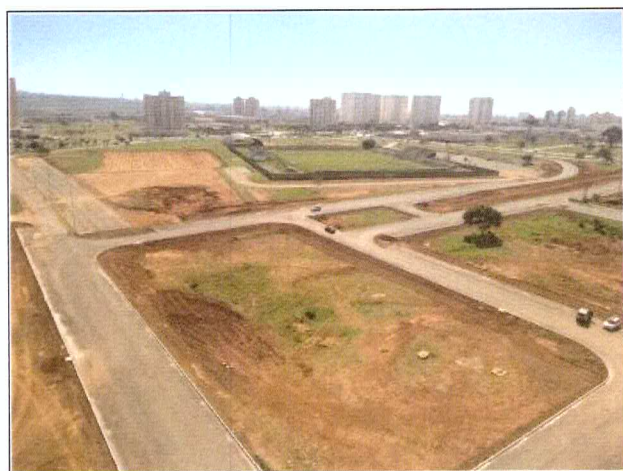
Entrega da Obra Centro Urbano
