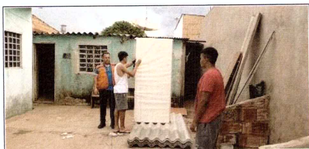
Ação junto às famílias atingidas pela chuvas - Destelhamento
